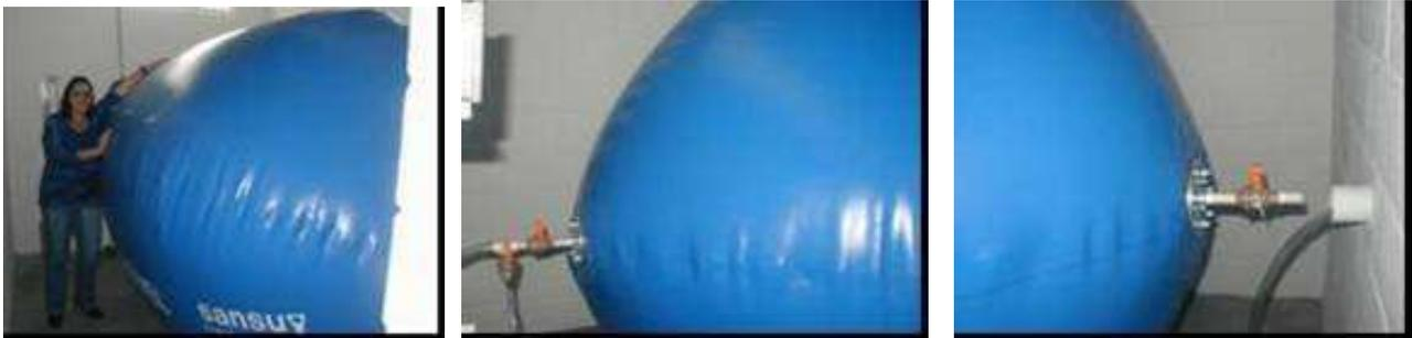
Figura 42. Fotos do gasômetro: armazenador de biogás.
