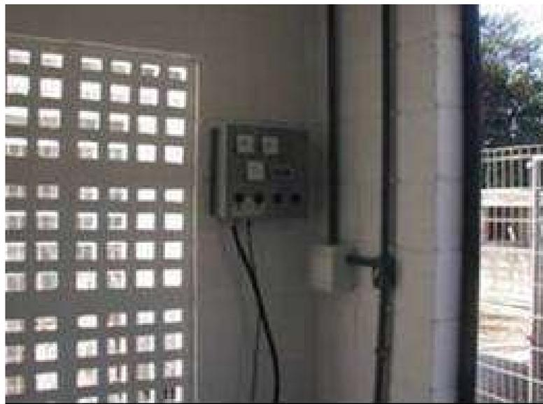
Figura 44. Painel de comando do grupo motor-gerador.
