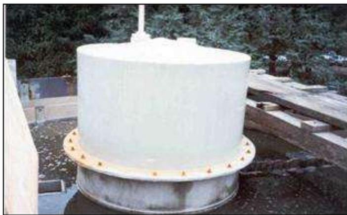
Figura 29. Alongamento da secção de captação do biogás.
