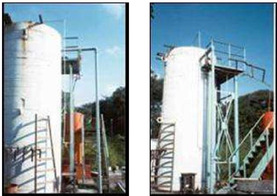
Figura 31. Fotos da tubulação de biogás instalada.
