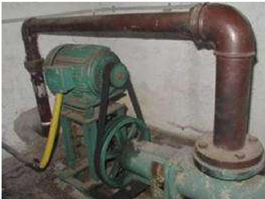
Figura 27. Bomba que leva o efluente para o biodigestor.
