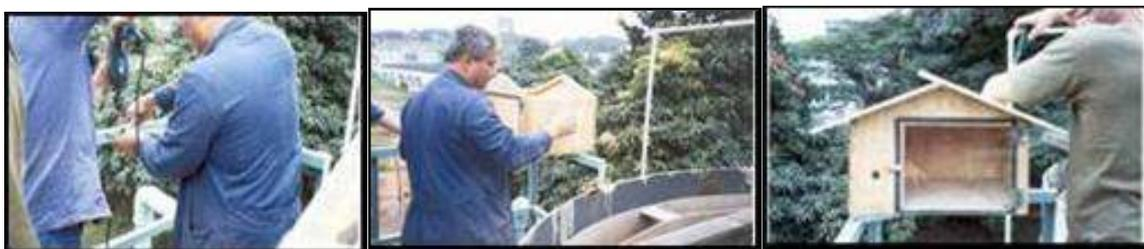
Figura 34. Fotos da instalação do abrigo para o medidor de vazão de biogás.
