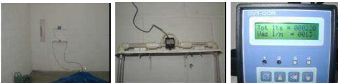
Figura 41. Fotos do medidor e totalizador de vazão de biogás instalados no abrigo.
